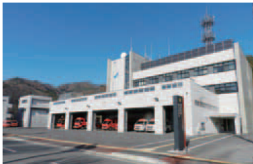
完成した釜石消防署庁舎
