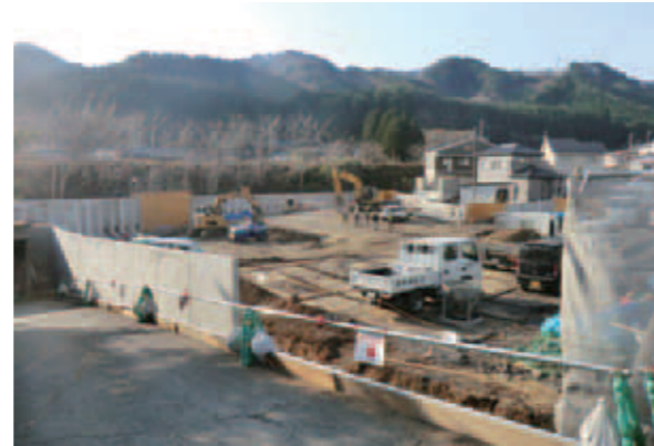
吉里吉里 B 団地造成工事の光景
