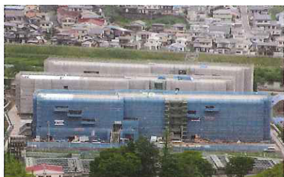
27年9月入居予定の災害公営住宅
