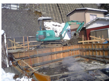
住宅再建工事中の現場
