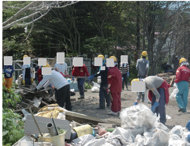
ガレキ撤去作業
