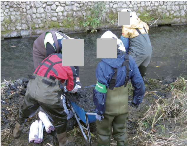
ヘドロのかき出し作業
