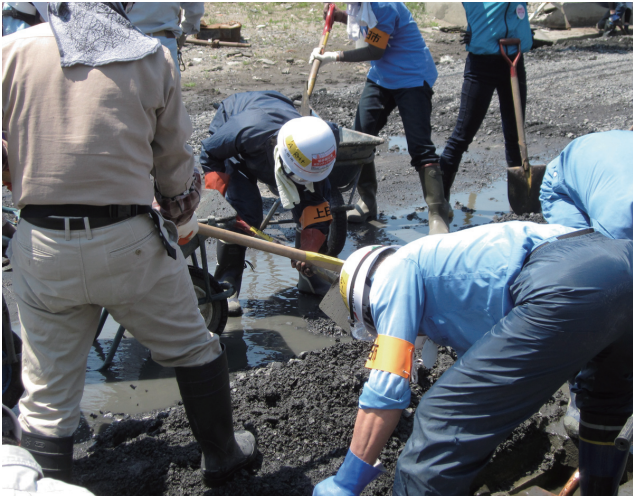
安渡地区側溝の泥だし作業
