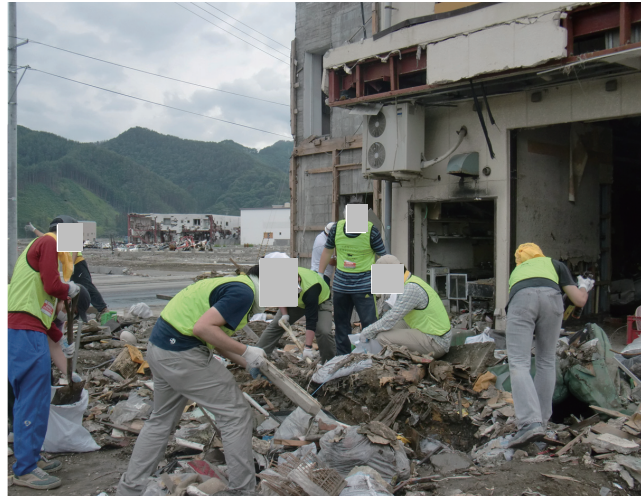
ガレキ撤去作業
