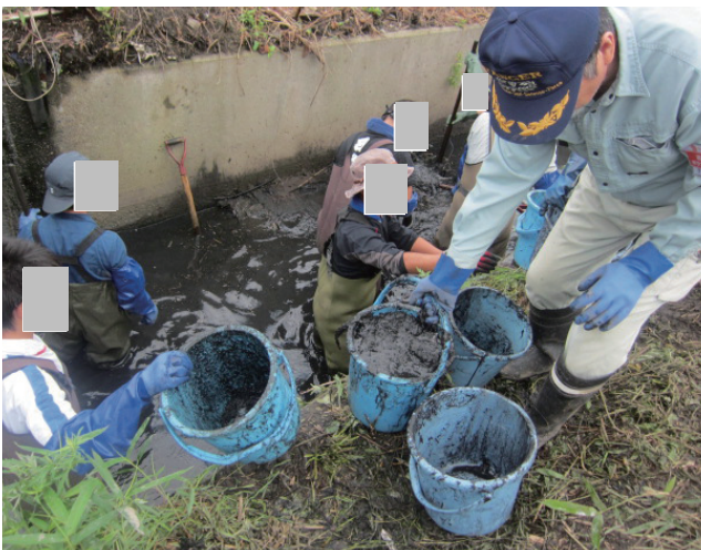
大ヶ口地区側溝の泥だし作業
