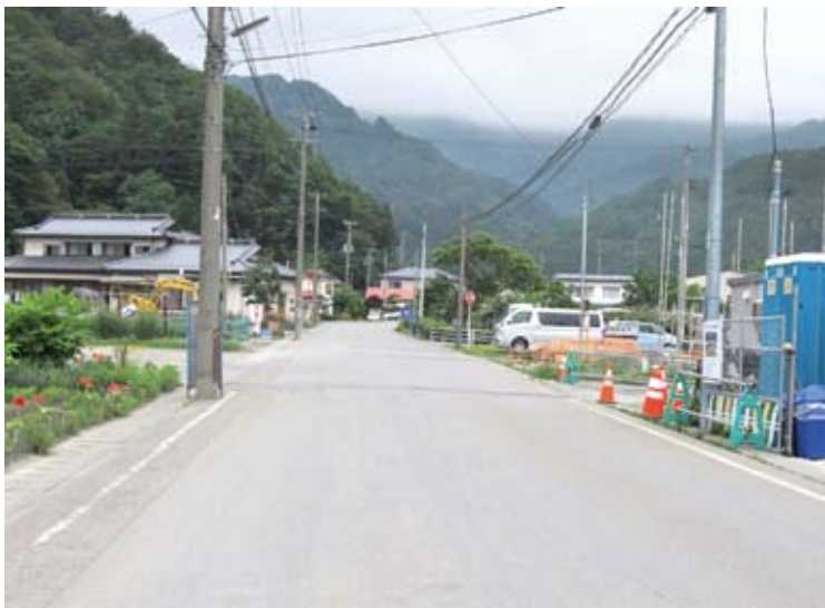
大ケ口地区幹線管路（第6工区）新設工事予定地
