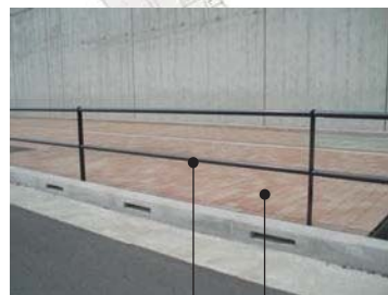
シンプルな横断防止柵 景観に配慮した歩道舗装
