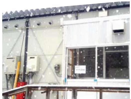
柔軟な対応が求められている仮設住宅の空き室
