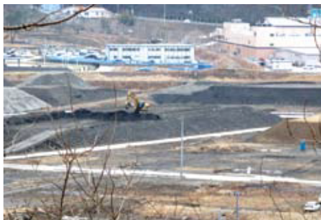
本格的に始まった町方地区盛土工事
