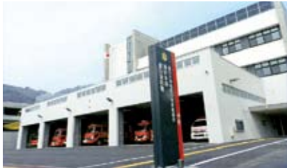
完成した釜石消防署庁舎本部
