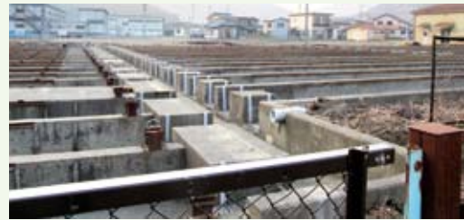
改修される大槌川第二ふ化場
