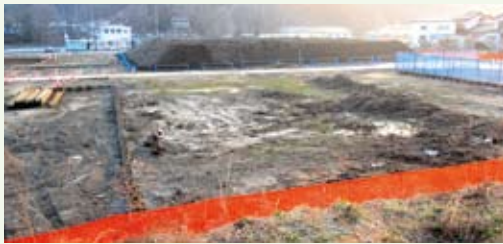
整備が進む旧大槌中学校跡地
