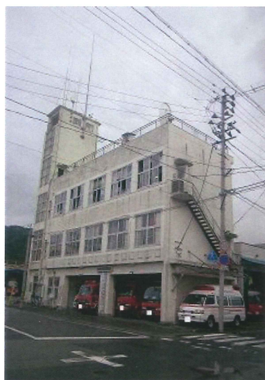
釜石大槌地区行政事務組合消防本部 釜石消防署
